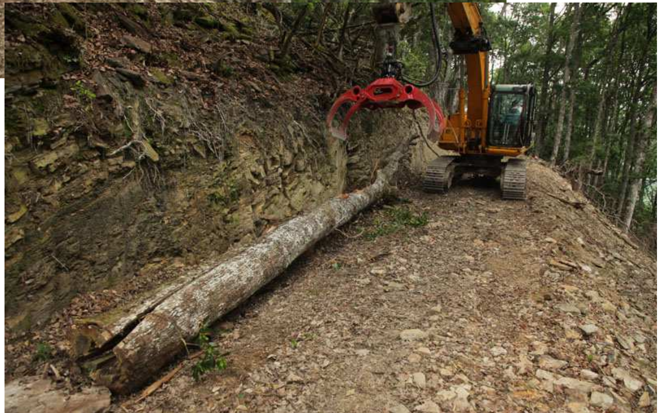
Finalmente, la retro coloca el tronco en un borde de la pista, haciendo uso de la pinza
